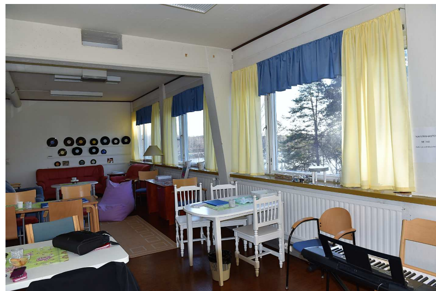
Kuva: Pilari-palkkirakenne jää näkyville paikoitellen myös IV-kerroksen tiloissa.
