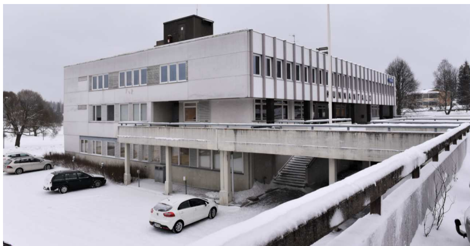
Kuva: Kunnantalon eduspiha on betonikannella. Itäpäädyssä on purettu portaikko, pohjakerrokseen on avattu ikkunoita ja I-kerroksessa suurennettu ikkunoita.
