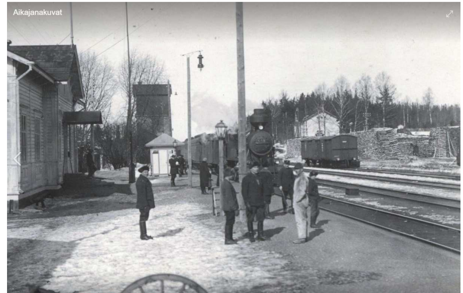
Kuva: Mäntyharjun rautatieasema. Takana näkyy vesitorni ja rautatieläisten asuinrakennus. / Kuvaaja Nestor Kurvinen, Mäntyharjun museon valokuvat
