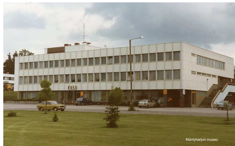
Kuva: Pohjoissivu vanhassa asussaan. Rakennuksessa on kiertoikkunat, joita jonkin verran käytettiin 60–70-luvuilla. Itäpäädyn portaat on sittemmin purettu. I-kerroksen ikkunat suurennettu. /Mäntyharjun museo, kuvaaja Hannu Heilio 1980.
