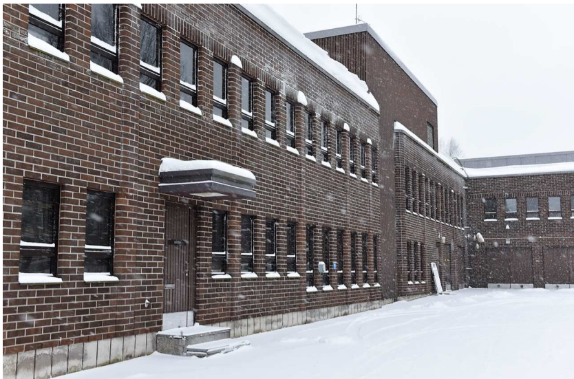
Kuva: Karun tiilifasadin pintastruktuuria on pehmennetty pyöristetyillä kulmilla. Puhtaaksimuurattuja julkisivuja ryhmittävät matalaprofiilliset liseinit ja vaakasuuntainen muurattu koristenauha yläkerroksen ikkunoiden yläpuolelle.
