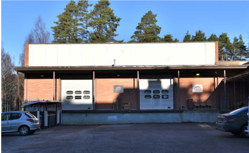
Kuva: Länteen työntyväkaksikerroksinen vinkkeli (D) on toteutettu rinneratkaisuna. Sivuseinällä on isot nosto-ovet ja lastauslaituri, päädyssä lipan suojaama sisäänkäynti alakerrokseen.
