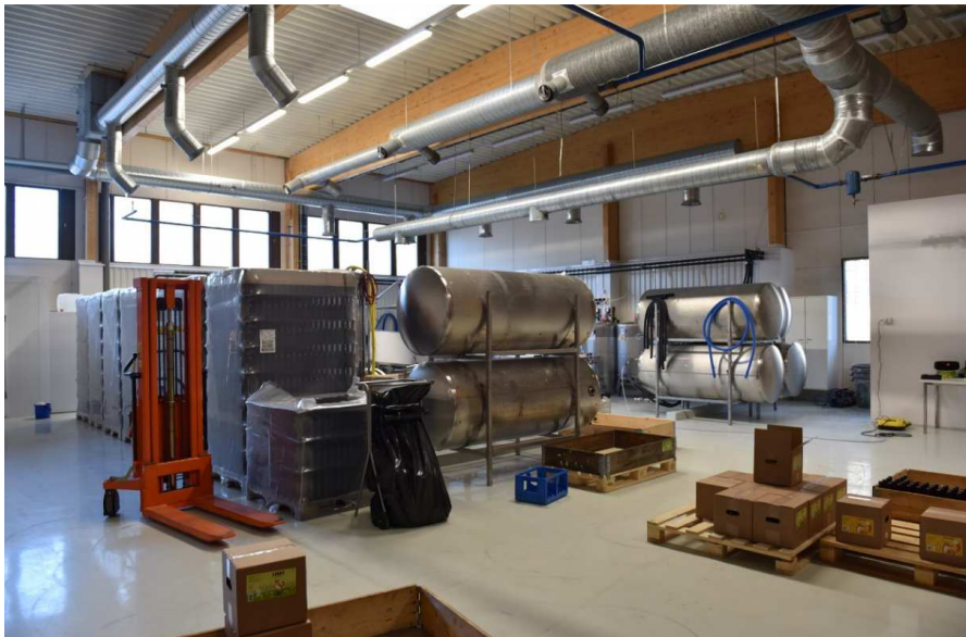
Kuva: D-osan yläkerroksen halli, entinen kenkätehtaan varasto, nykyään pienpanimo.
