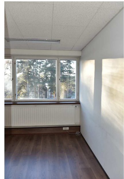
Kuva: Työhuone. Uusi laminaatti.
