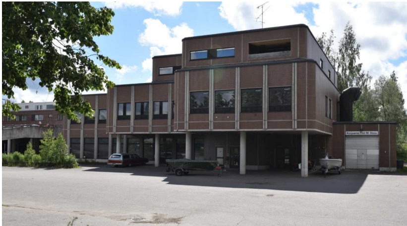
Kuva: Säästöpankin pohjakerroksessa oli tavaratalo, aulakahvio ja pankin arkisto, I-kerroksessa pankki ja yksi myymälähuone. Yläkerrassa oli sosiaalitalit sekä kerho- ja saunatilat. Kerrokset ovat pinta-alaltaan ja pohjaratkaisultaan erilaiset, mutta jokaisessa kerroksessa on keskusaula. Julkisivuissa on keraaminen laattaverhous.
