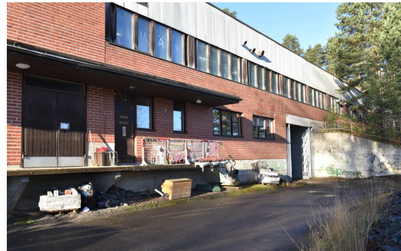
Kuva: C-siiven nauhafasadi. Lastauslaituri on 1960- ja 1970-luvuilla rakennettujen siipien B ja C liitoskohdassa.
