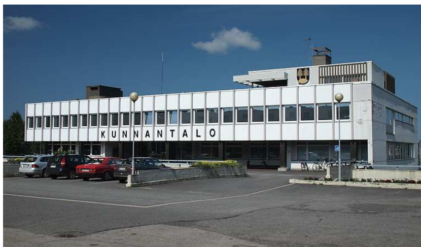
Kuva 2017: Syvennykseen on vaihdettu puitejaoltaan alkuperäisistä poikkeavat ikkunat. II-kerroksen metalliset ikkunapuitteet ovat paksummat kuin alkuperäisissä ikkunoissa, ja tämä on muuttanut hieman julkisivujen struktuuria. Alkuperäiseen suunnitelmaan kuulunut betoniseinäinen kioski on purettu. Päädyn I-kerroksen ikkunat on suurennettu,
