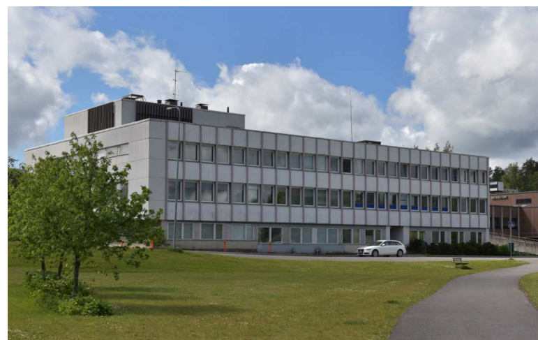
Kuva 2017: Pohjakerroksen liiketilojen lasiseinät on korvattu pienemmillä puiikkunoilla. Kulmalla ollut sisäänveto on poistettu, samoin sisäänkäynnit yhtä lukuun ottamatta. Sokkelista on poistettu klinkkeriverhous. Muutokset eivät ole tue rakennuksen alkuperäistä, horisontaalisuutta korostavaa julkisivujäsentelyä, jossa tumma tai sisäänvedetty alakerros visuaalisesti irrotti vaalean rakennuksen maasta.
