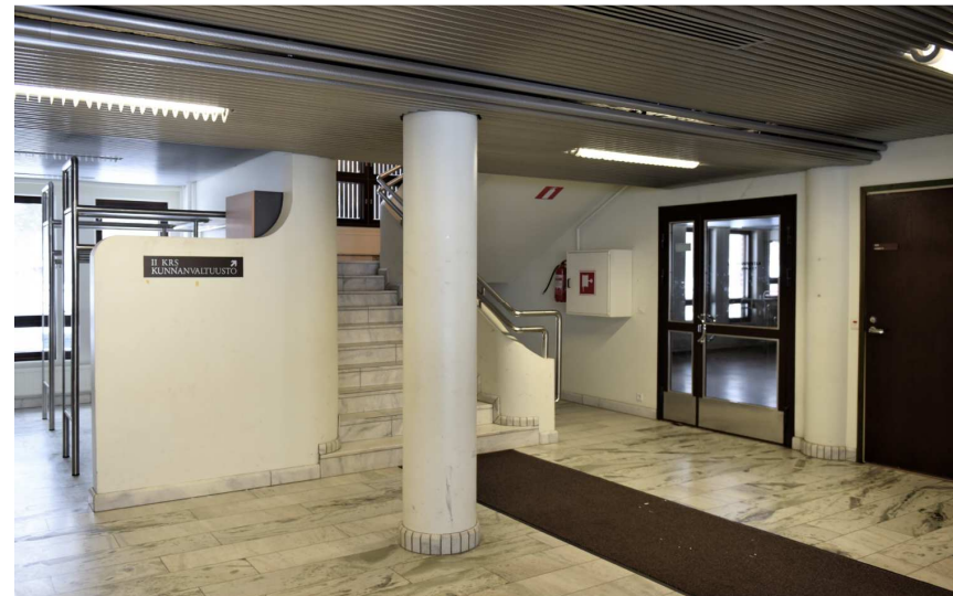
Kuva: Virastokeskuksen sisääntuloaula. Katossa on metallisäleverhous. Portaat sekä lattialaatat ja -listat ja ovat marmoria.
