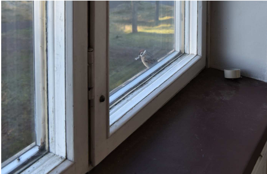
Kuva: 1960-luvulla rakennetussa IV-kerroksessa on vanhat kolmilasiset ikkunat. Ikkunapenkki on betonia ja maalattu.
