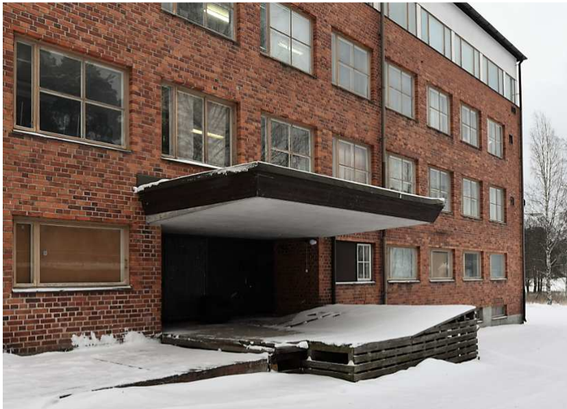
Kuva: Länteen työntyväkaksikerroksinen vinkkeli (D) on toteutettu rinneratkaisuna. Sivuseinällä on isot nosto-ovet ja lastauslaituri, päädyssä lipan suojaama sisäänkäynti alakerrokseen.
