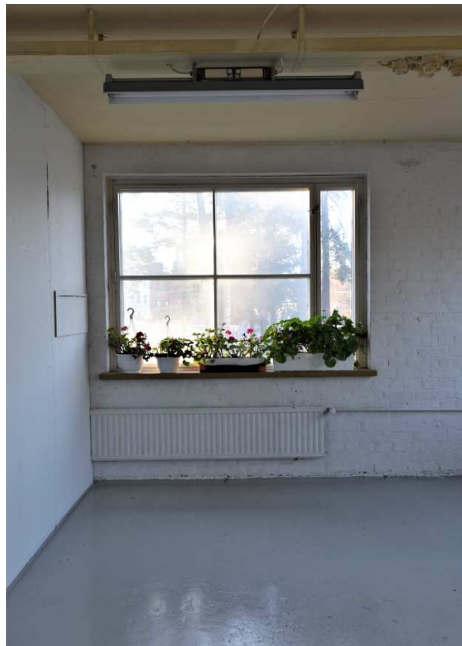
Kuva: II-kerroksen työhuone, joka on erotettu isosta tilasta kevyillä väliseinillä. Ulkoseinä on kevyesti rapattua ja maalattua tiiliseinää. Isot ikkunat ovat tyypillisiä tehdasrakennuksille. Vanhaa ilmettä on saatu jakamalla karmijaoltaan tyypillinen 50-luvun ikkuna kapeilla pienoilla neljään ruutuun.
