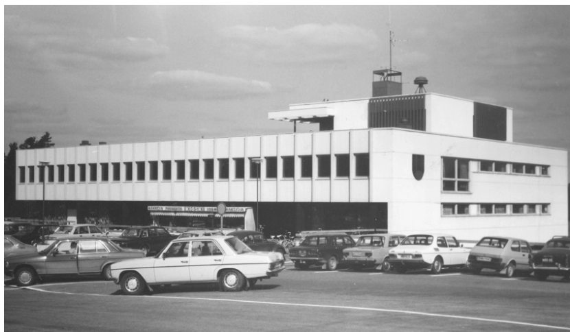
Kuva: Kunnantalon pääfasadi etelään. Rakennuksen katolla on teknisiä tiloja sekä entinen valtuustosalin lehteri ja kattoterassi. Ikkunat antavat luonnonvaloa alapuoliseen valtuustosaliin. Pääoven edustalla on Grillikioski. / Mäntyharjun museo, kuvaaja Hannu Heilio 1980.
