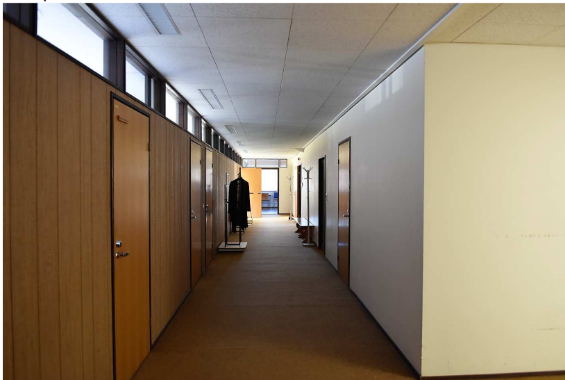
Kuva: IV-kerroksen käytävä, johon väliseinän nauhaikkuna päästää luonnonvaloa. Värimaailma on ruskeavoittoinen. Materiaalit ovat pitkälti 1980-luvun peruskorjauksesta.
